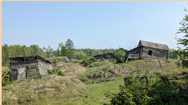
Термокарстовые просадки (былаары), разрушение строений и дорог, пагубное влияние на лес.
